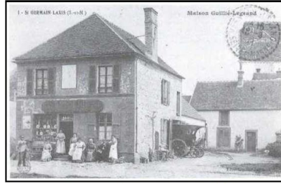
Maison le long de la RN 36
