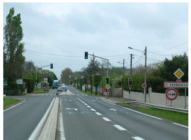
La RD 636 en venant de l'échangeur de l'A5 : entrée de ville Nord avec des feux tricolores. Accès vers la zone d'activités sur la gauche et, zone d'habitat, le long de la voie bordée d'arbres.
