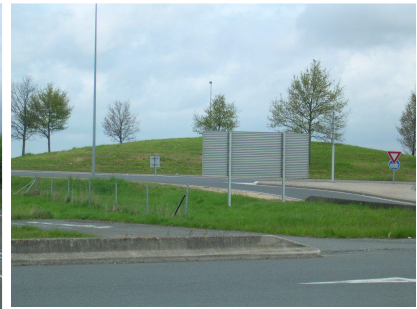
Rond point reliant la sortie de l'A5 et la RD 636
