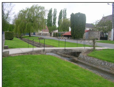
Ponts du Ru d'Andy dans le centre bourg
