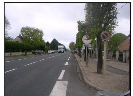
Logements individuels le long de la RD 36 avec passages piétonniers
